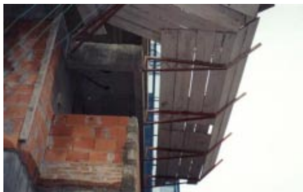
Figura 1. Fresta entre a plataforma e a laje, criando situação de risco.
