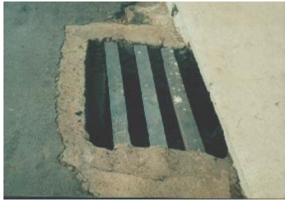
Figura 2 – Fotografia de boca-de-lobo com grelha em trilhos
