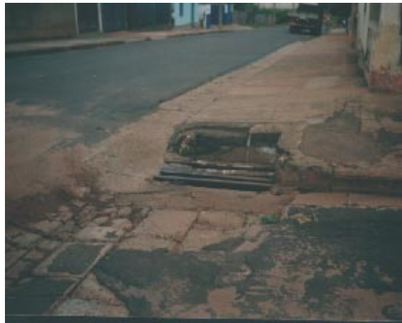
Figura 5 – Boca-de-Lobo com Grelha Fixa, no Passeio – Risco aos Pedestres
