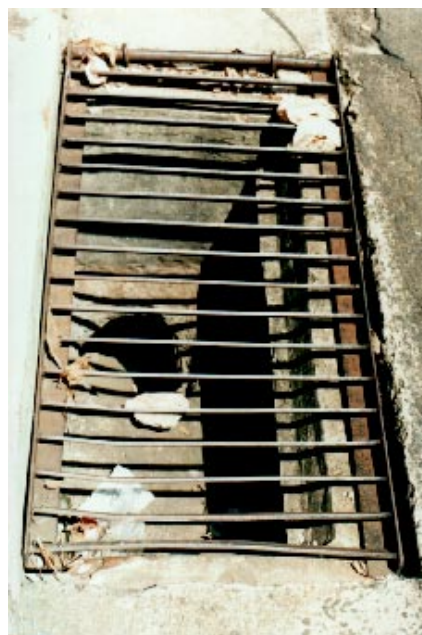
Figura 3 – Fotografia de boca-de-lobo com grelha, composta de barras perpendiculares ao fluxo
