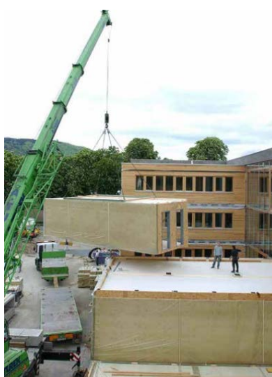
Figura 3 - Movimentação de módulo em CLT no canteiro
