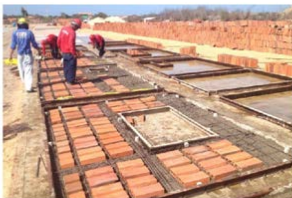
Figura 2 – Processo de fabricação de paredes de habitações populares no sistema Casa Express (a) e içamento dos painéis (b)
