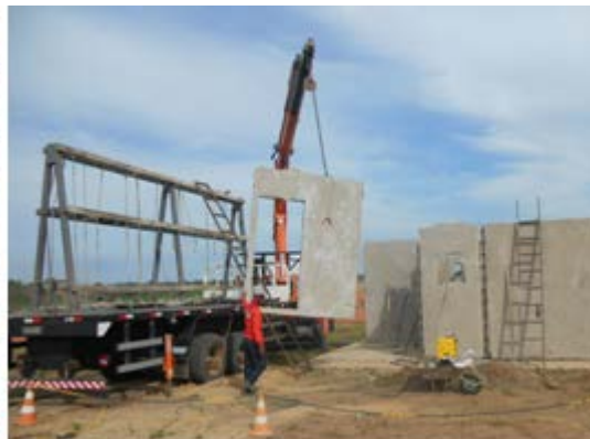
Figura 2 – Processo de fabricação de paredes de habitações populares no sistema Casa Express (a) e içamento dos painéis (b)
