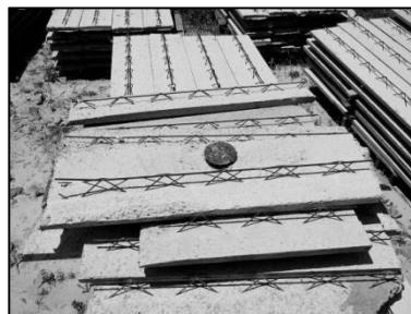
Figura 1 – Caixas elétricas montadas nas peças de laje treliçada (Obra "A")
