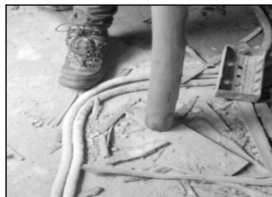
Figura 2 – Modelo de calço para escoramento da laje (Obra "B")
