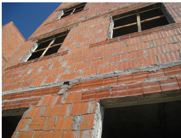
Figura 3 - Desaprumo, modulação e preenchimento das juntas de forma incorreta – Empreendimento AC
