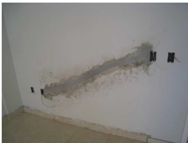
Figura 4 – Quebra em alvenaria – Empreendimento HPM
