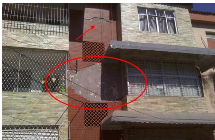
Figura 13 – Visualização de descolamento de placa cerâmica vermelha
