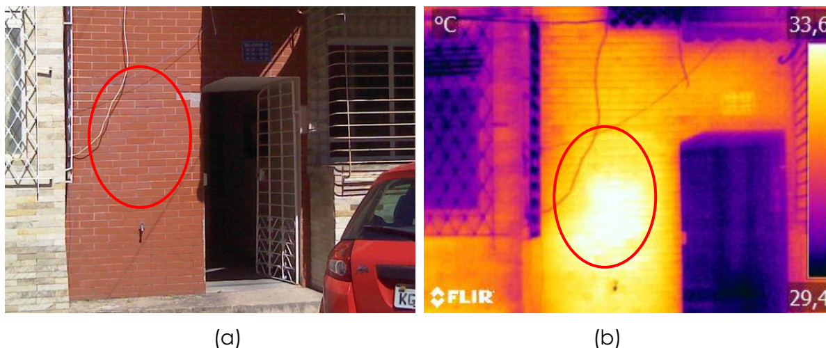
Figura 15 – Local que visivelmente não apresenta manifestação patológica (a) e região de temperatura mais elevada indicando um descolamento (b)
