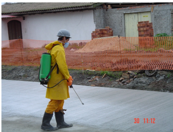
Figura 6 – Cura química aplicada com pulverizador
