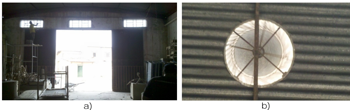
Figura 4 – (a) Aberturas na fachada orientada a 135° e (b) detalhe do exaustor eólico instalado na cumeeira
