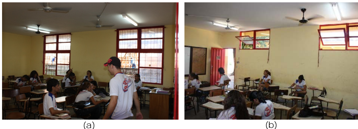
Figura 8 – (a) Região mal iluminada entre janelas baixas e (b) iluminação no centro da sala e próximo às janelas altas
