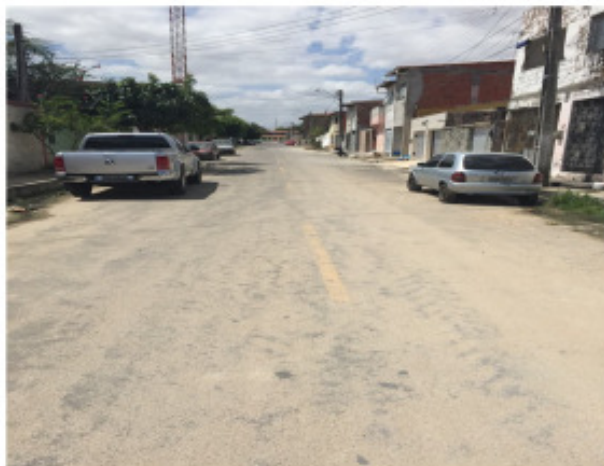
Figura 5 – Rua do empreendimento
