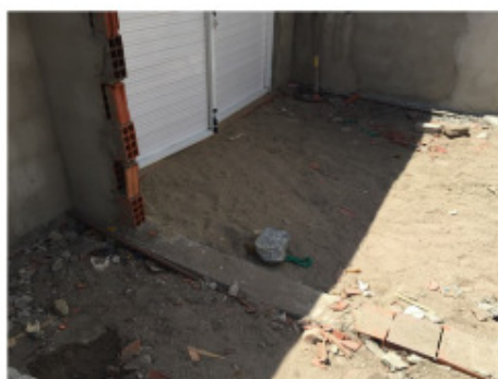
Figura 8– Medição individualizada de água
