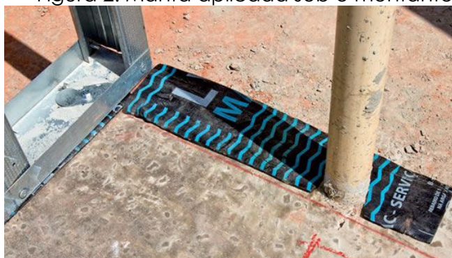
Figura 2: Manta aplicada sob o montante.
