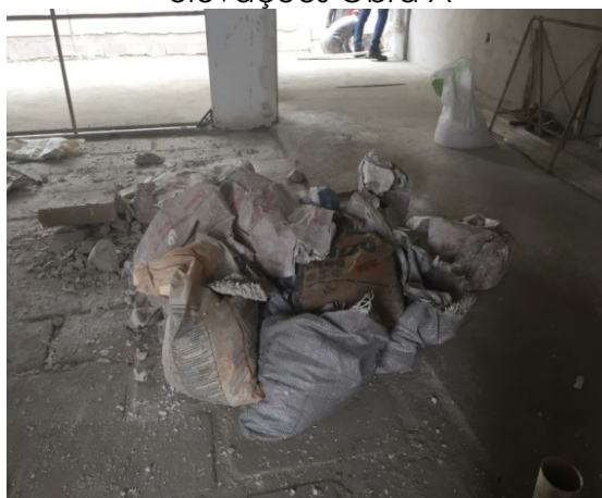
Figura 02 - Resíduo de gesso nas elevações Obra A
