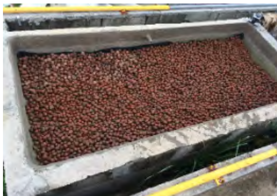
Figura 9 – Camada de drenagem executada.
