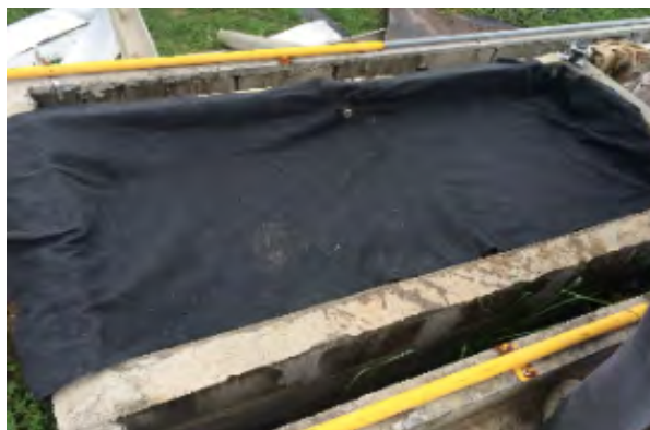
Figura 10 – Manta geotêxtil colocada sobre a camada drenante.
