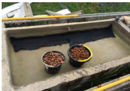
Figura 8 – Colocação da manta geotêxtil para proteção dos tubos.
