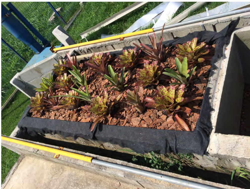
Figura 15 – Protótipo de telhado verde concluído.
