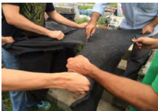
Figura 7 – Recorte da manta geotêxtil nas dimensões necessárias.
