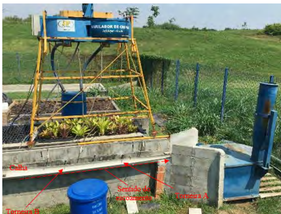
Figura 6 – Saídas da drenagem do protótipo.
