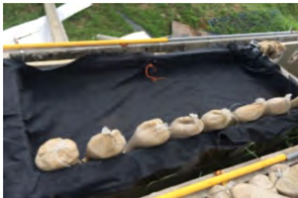
Figura 11 – Primeira fileira de sacos com areia para compor o substrato.
