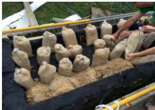
Figura 12 – Processo de lançamento da areia dos sacos para o protótipo.
