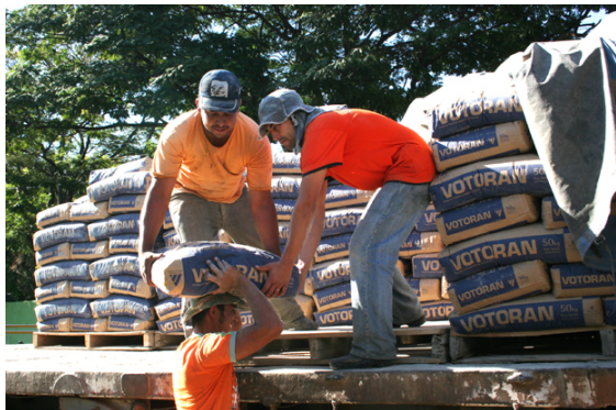
Figura 1- Descarga manual de sacos de cimento
