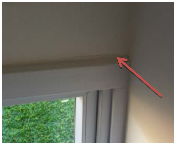
Figura 1 - Fissura no canto superior da esquadria
