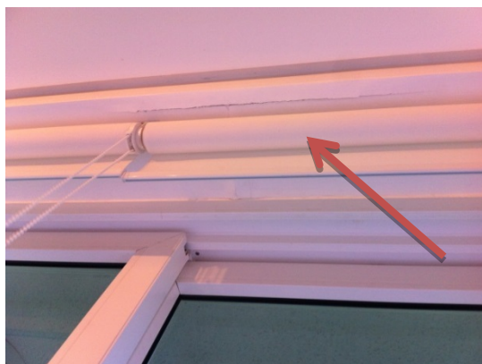
Figura 4 - Fissura no teto da sala de jantar
