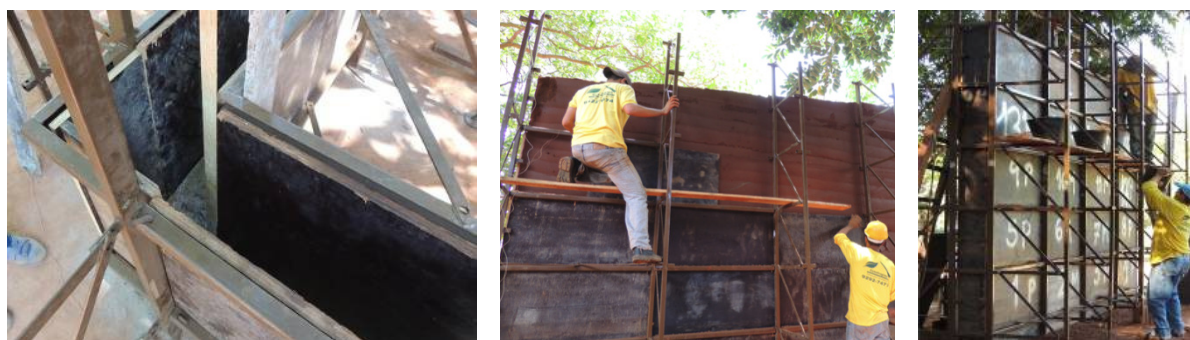
Figura 3 – Formas utilizadas para a construção das paredes.
