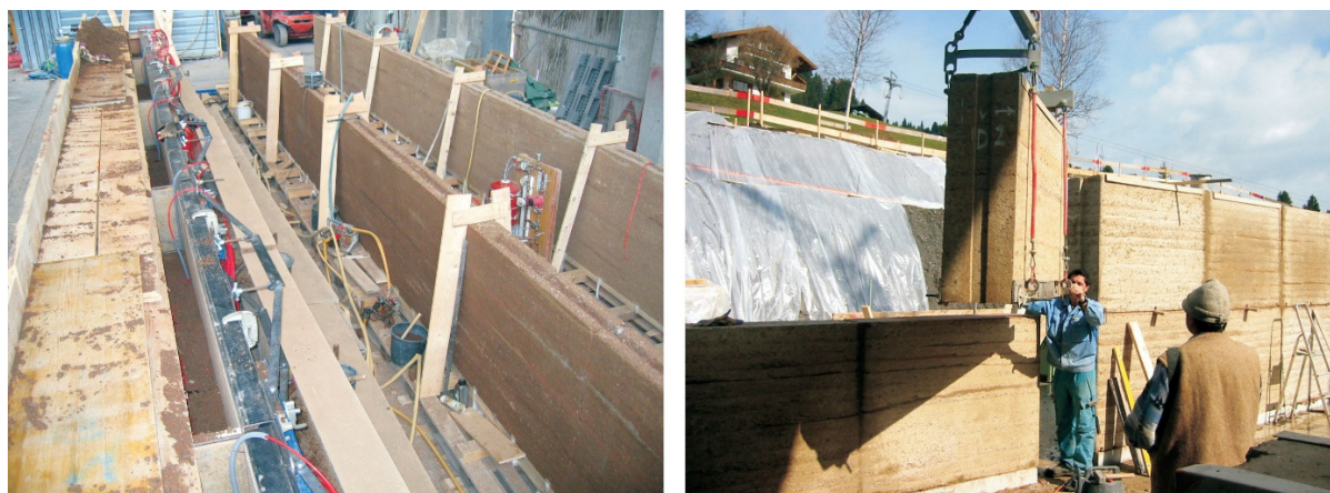
Figura 2 - Taipa pré-fabricada sendo produzida e instalada na obra.
