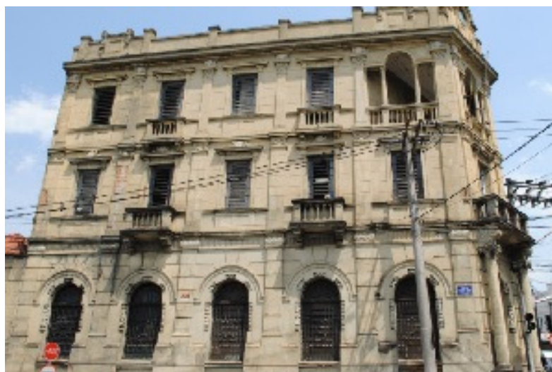
Figura 1 – Palacete Scarpa, biblioteca do Museu Ferroviário de Sorocaba
