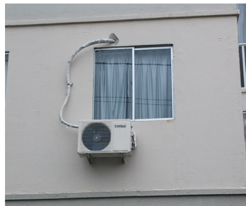
Figura 4 – Parede em concreto, perfurada para instalação de aparelho de ar-condicionado tipo split
