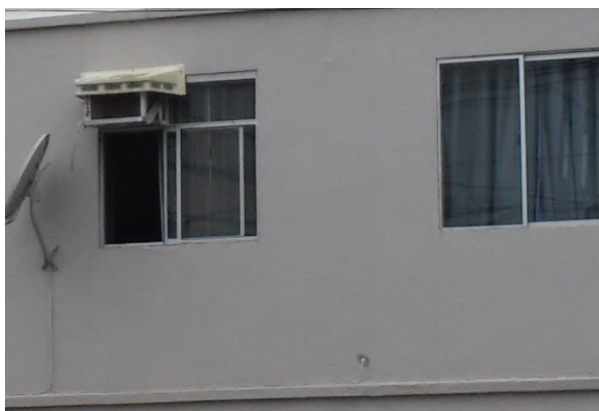
Figura 3 – Substituição da esquadria original para permitir a instalação do aparelho de ar-condicionado
