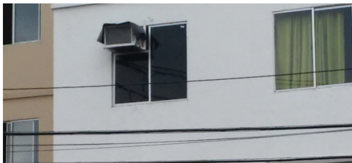
Figura 2 – Aparelho de ar-condicionado inviabilizando a abertura da janela
