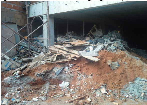
Figura 2 – Resíduo não segregado (Obra C)
