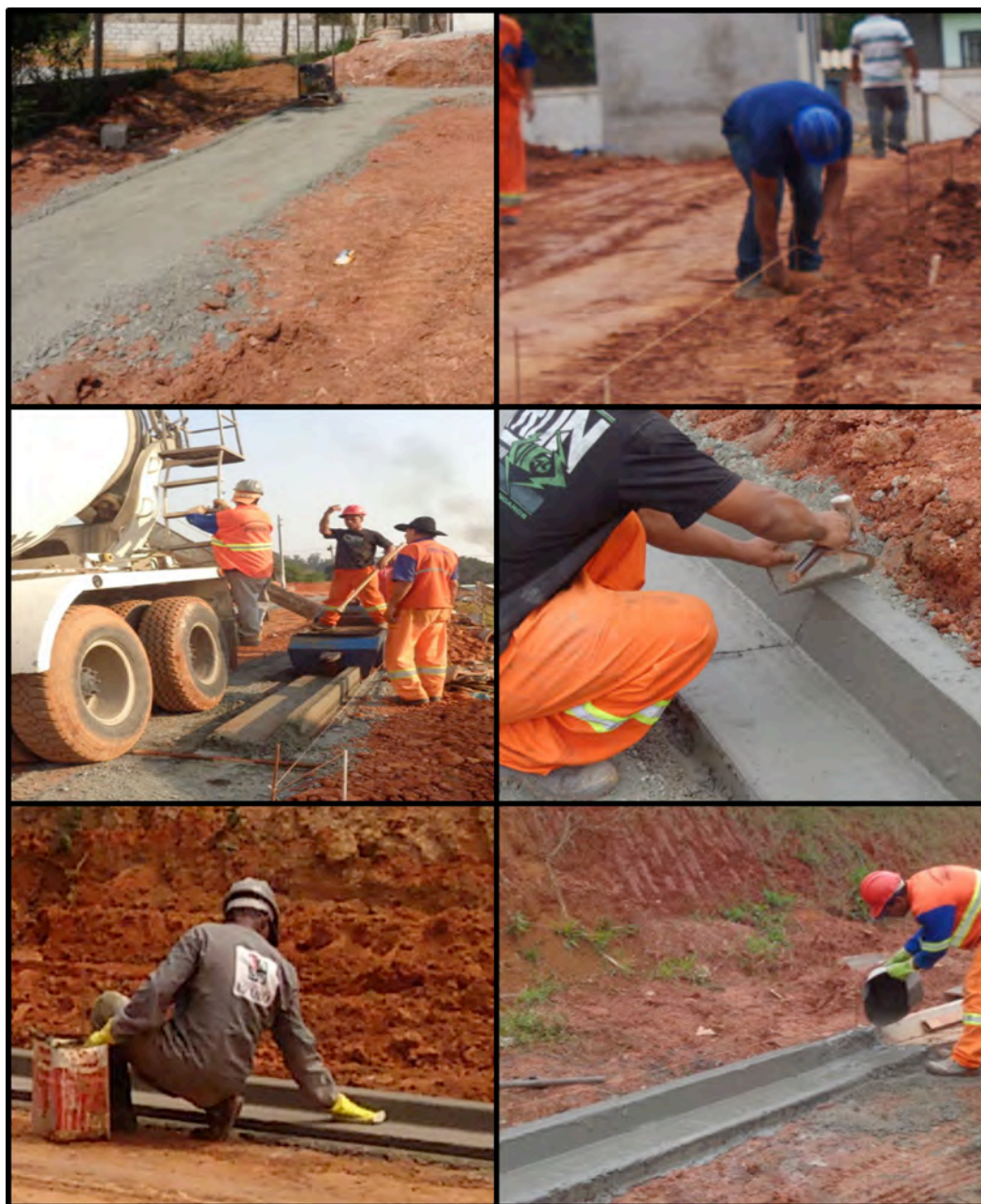
Figura 5 – Sequência executiva para guias moldadas “in loco” com equipamento de extrusão de concreto
