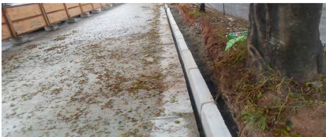
Figura 2 – Guias moldadas “in loco” com equipamento extrusor de concreto
