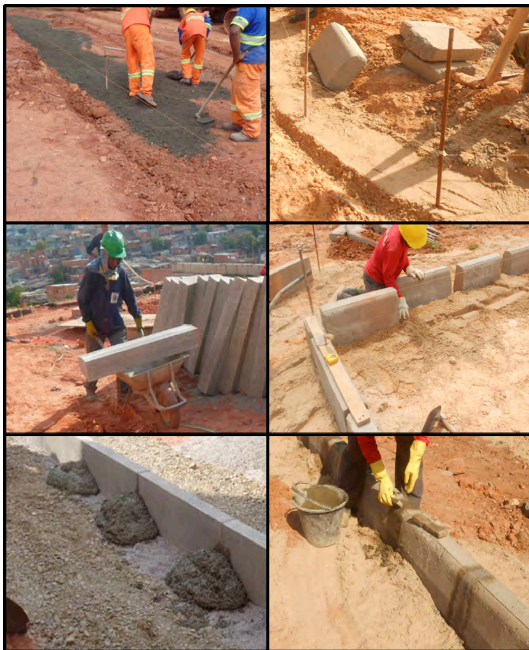
Figura 4 – Sequência executiva para guias pré-moldadas de concreto
