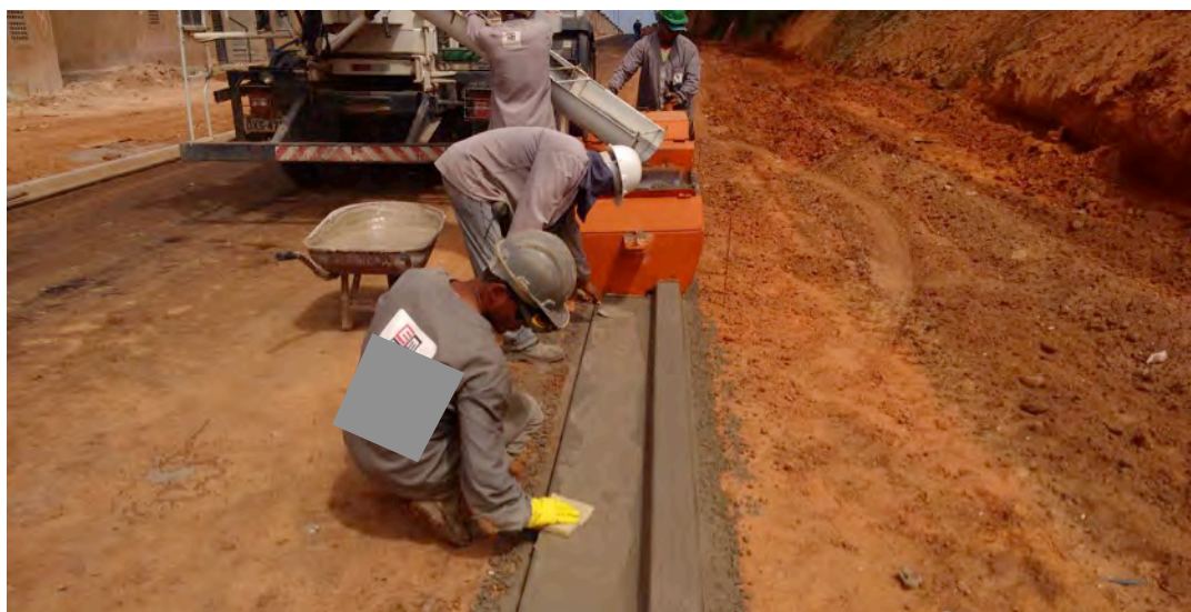
Figura 2 – Guias moldadas “in loco” com equipamento extrusor de concreto
