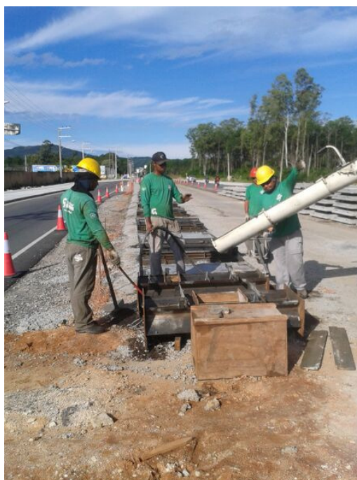
Figura 01– Operários concretando as escamas no canteiro
