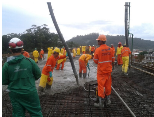
Figura 04- Concretagem das transversinas e longarinas com duas frentes
