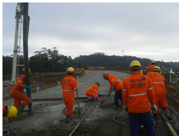
Figura 05- Concretagem da laje superior com apenas uma frente
