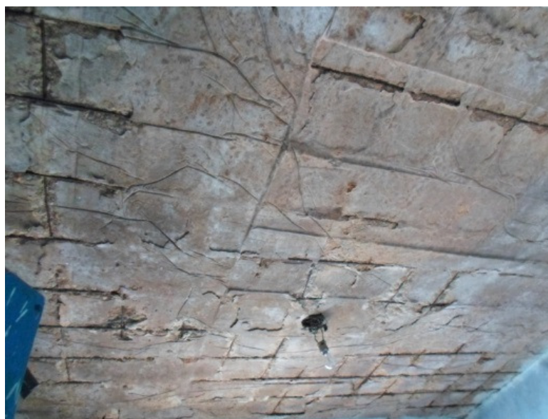
Figura 4 – Laje com trincas, armaduras descobertas e em processo de corrosão
