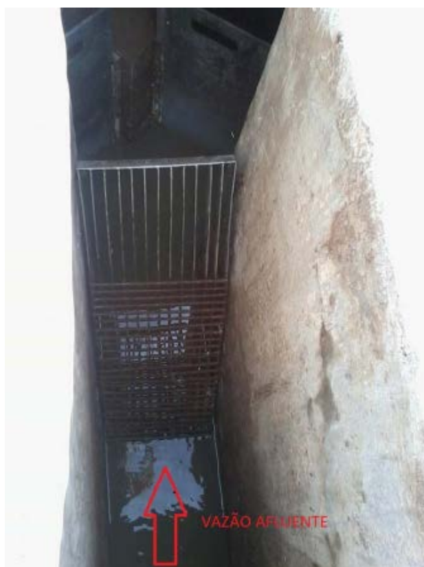
Figura 3 – Tratamento Preliminar ETE da IES – Gradeamento
