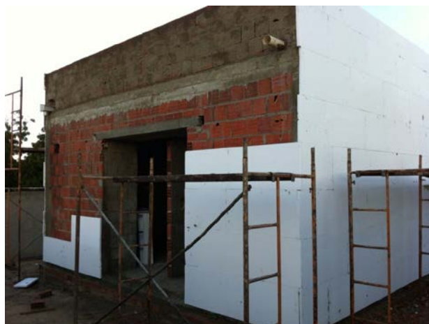
Figura 2 – Aplicação do sistema ETICS
