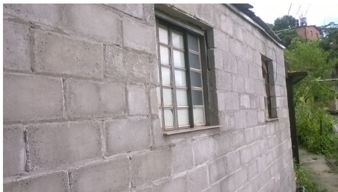
Figura 13 – Foto da casa 2 após a aplicação do bloco de concreto leve
