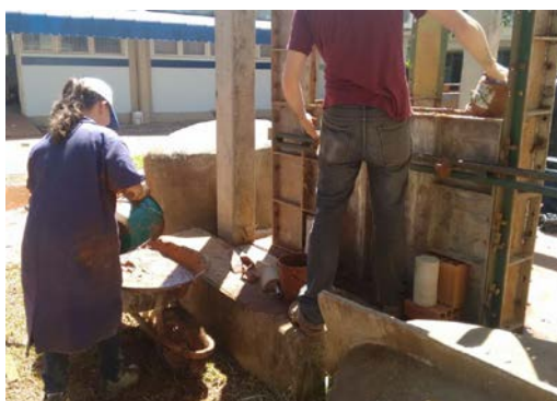
Figura 3 – Lançamento da mistura de SCAA na forma
