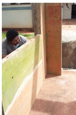
(a) Montagem da forma em L
