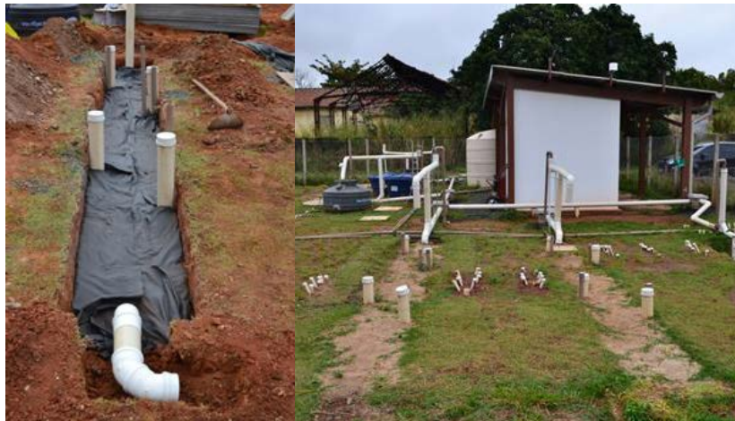
Figura 3 – Detalhe esquemático da trincheira de infiltração experimental.
