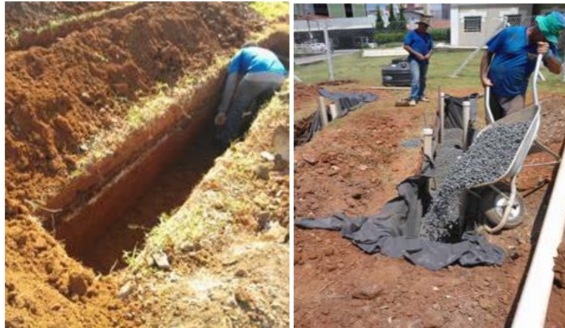
Figura 2 – Fase final da instalação das trincheiras de infiltração.
