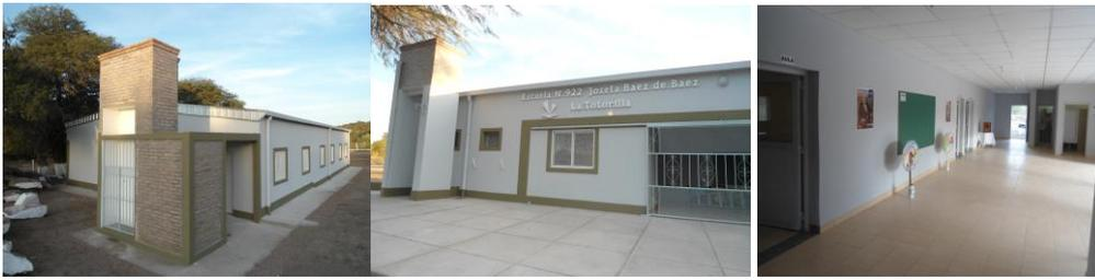
Figura 12 - Fotografías de Escuela: Mampostería de ladrillo macizo, techo con estructura y cubierta metálica y cielorraso suspendido.
