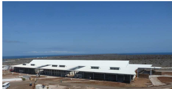
Aeropuerto Ecológico de Islas Galápagos, construido y operando, certificado LEED Gold, USGBC, 2014.
