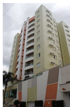
Figura 6: Fachada frontal Sudeste Fonte: Jakelline Kuba
