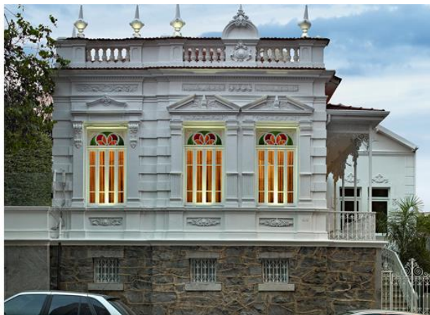
Figura 1 – Fachada do Escritório Gustavo Penna Arquiteto & Associados.
