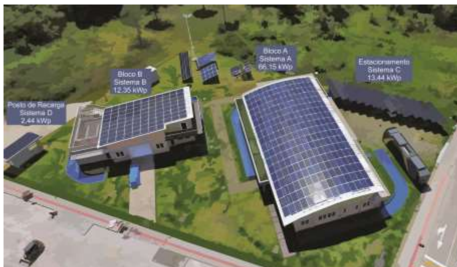
Figura 1- Sistemas FV integrados ao Centro de Pesquisa e Capacitação em Energia Solar da UFSC.
