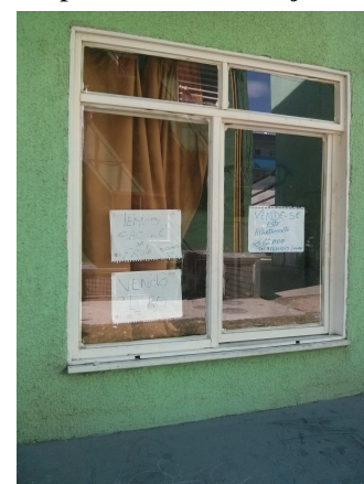
Figura 6 – Janela de um dos dormitórios no Conjunto. Fonte: Autores
