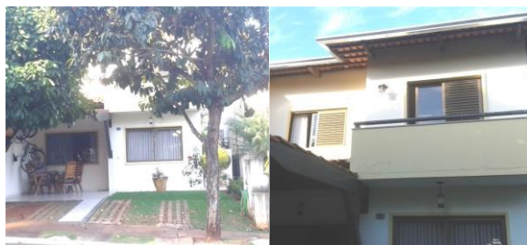
Figura 3 - Fachada frontal da residência monitorada.
