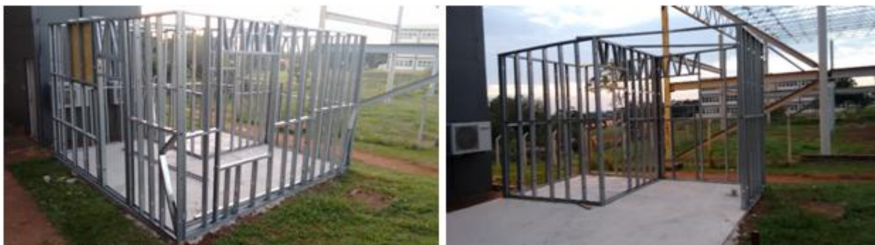
Figura 1 – Estrutura em Light Steel Frame.
