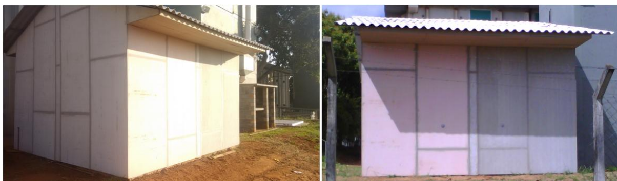
Figura 2 – Placas de fibrocimento fixadas na estrutura em LSF.
