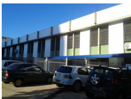
Figura 3: Fachada Leste das Alas de Clínica Médica e Cirúrgica do HC da UFTM. Foto: Autora (2014)
