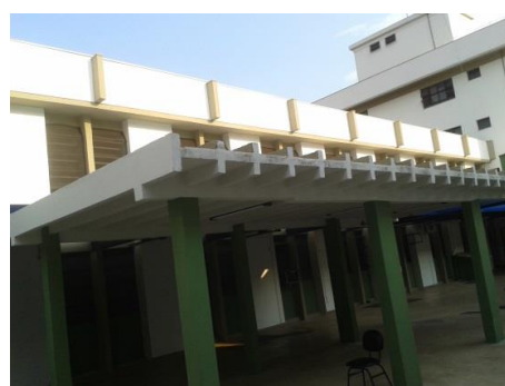
Figura 4: Fachada oeste, voltada para um pátio interno das Alas de Clínica Médica e Cirúrgica do HC da UFTM. Foto: Autora (2014)
