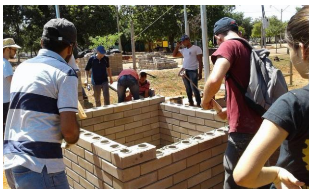
Figura 1 – Construção da célula-teste com bloco de solo-cimento com lodo incorporado desenvolvido pelo grupo TEMAS.
