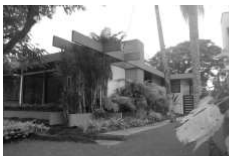
Figura 5 – Abertura da sala de jantar, face oeste e sul (LARRY, 2015).
