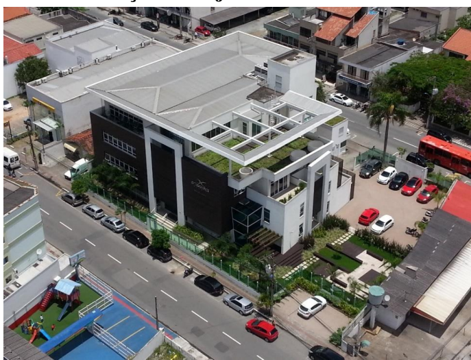
Figura 1 – Vista superior do edifício DC Logistics (Acervo da autora, 2016)
