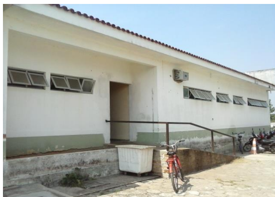
Figura 4 – Fachada externa da cozinha.
