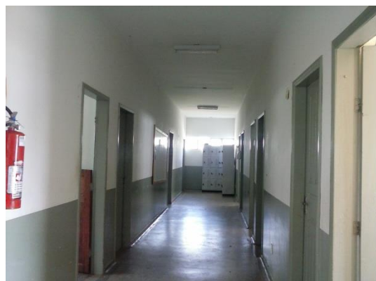
Figura 5 – Corredor adjacente à cozinha.
