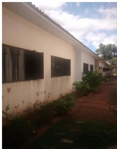
Figura 4: Fachada lateral do Bloco A (VASCONCELOS, 2016).
