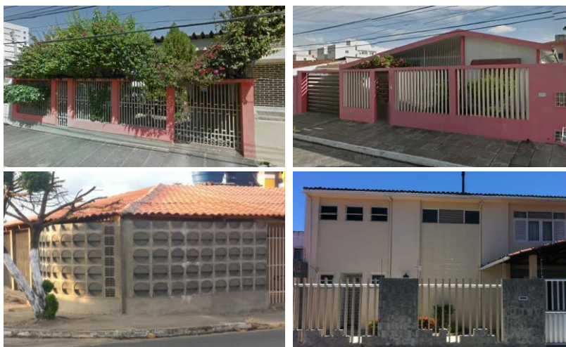
Figura 1 - Residências situadas em Maceió/AL com muros constituídos por diferentes elementos vazados.
