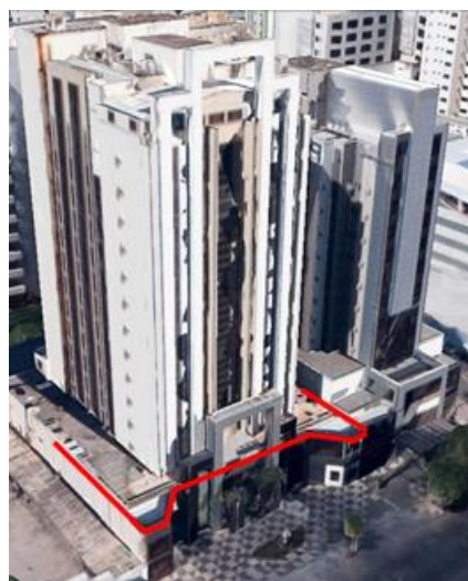
Figura 7 - Características da fachada da edificação em frente ao Receptor 1 (Adaptado de GOOGLE, 2015).
