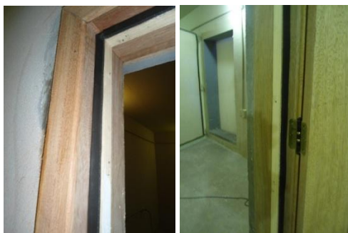
Figura 11 – Porta na situação do Ensaio 15
