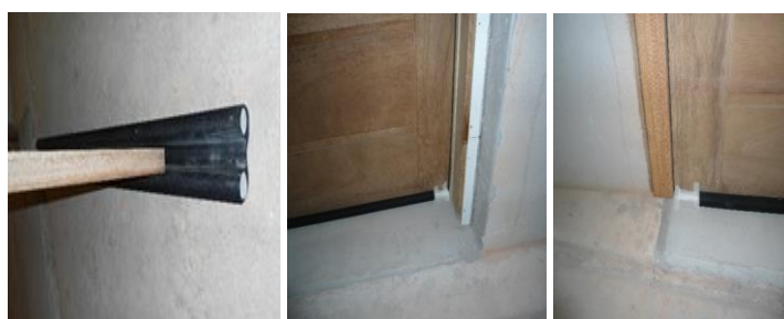
Figura 16 – Porta na situação do Ensaio 20
