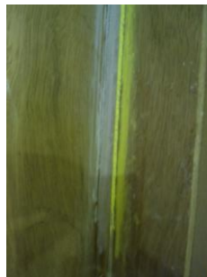
Figura 9 – Porta na situação do Ensaio 13
