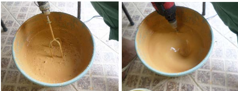
Figuras 16 e 17 – Preparação da tinta com haste de bateadeira e furadeira
