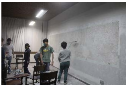
Figura 9 – Preparação da parede
