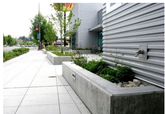
Figura 03 – Infraestrutura verde: canteiros pluviais. Fonte: Demantova, 2012.
