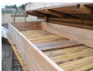
Figura 01. Estrutura do telhado verde
