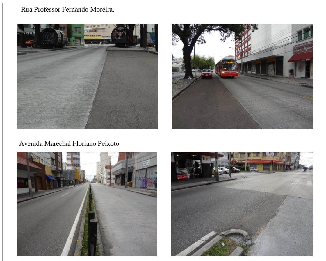
Figura 02 – Exemplos das diferenças de tonalidades entre o asfalto (mais escuro) e o concreto (mais claro).
