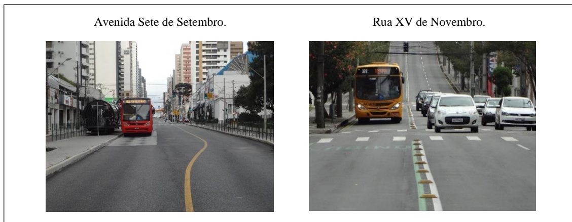
Figura 03 – Exemplos de canaleta exclusiva (ou corredor expresso) e via exclusiva para ônibus. Fonte: O autor (2014).
